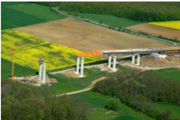
Abb. B 7/1: Bauarbeiten an der A 71-Trasse
